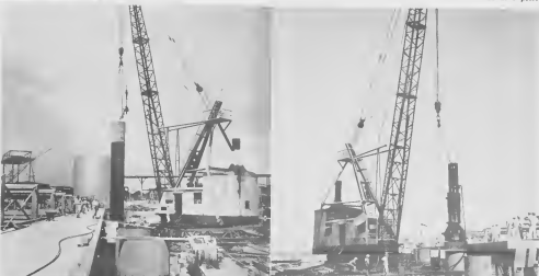
THIS MAN just fits in one of the four caissons driven on the pier at the south side. E HOMBER aki ta fiti den di un di e cuatro cajonnan mandá den banda di zuid di e pier.
